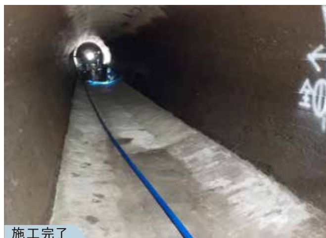
導水路トンネル インバート補修
