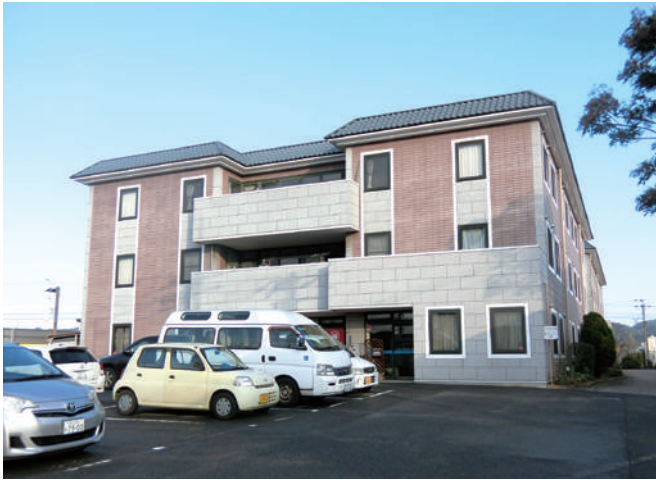
外壁改修工事
