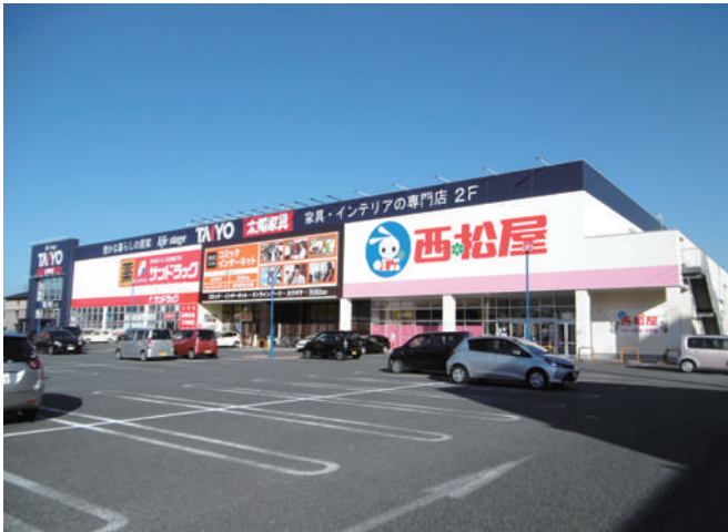
外壁改修工事
