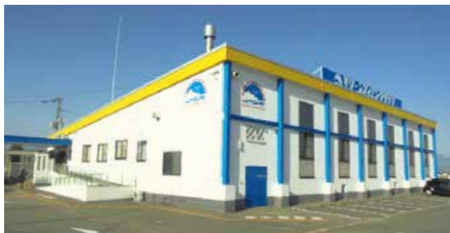
外装・屋根改修工事
