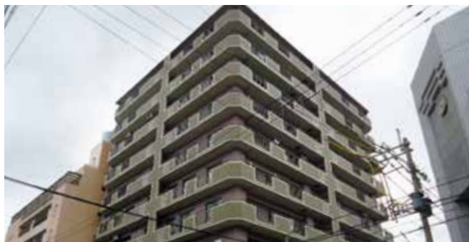
マンション大規模修繕工事
