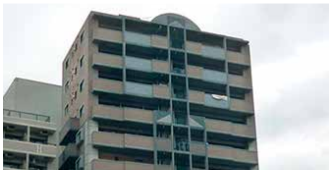
外壁改修工事
