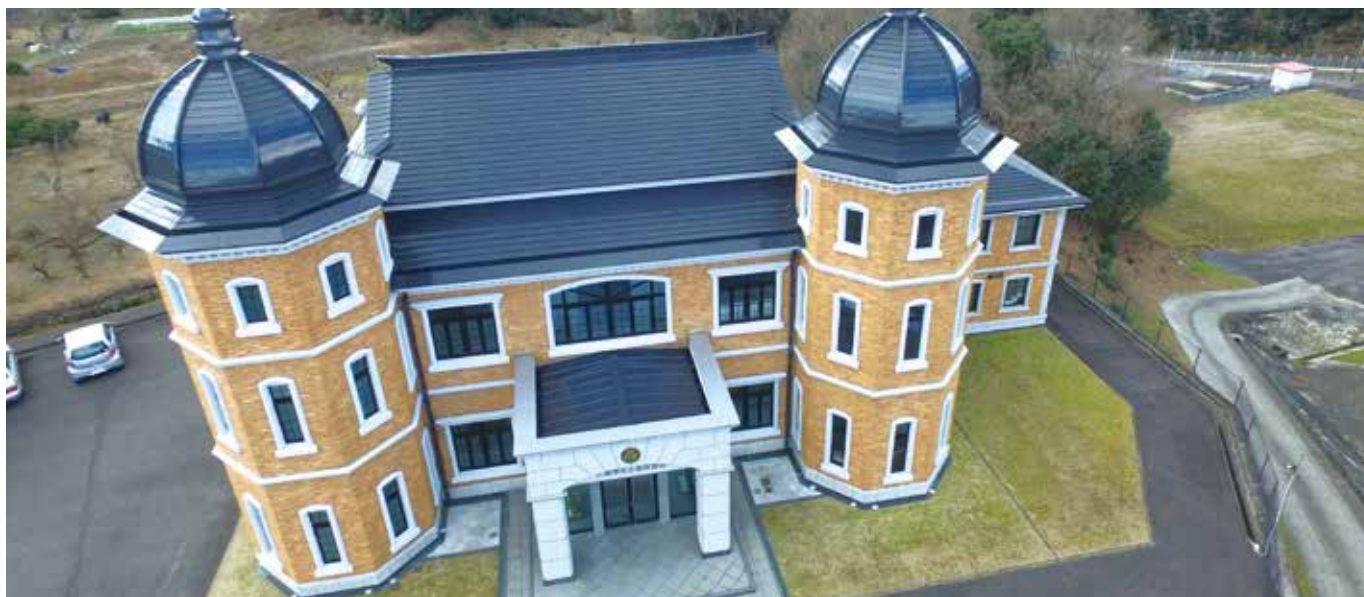
屋根及び外壁改修工事
