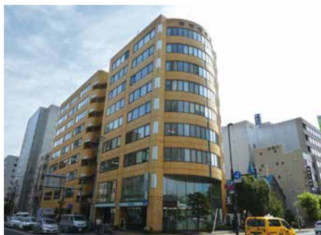
外壁改修工事
