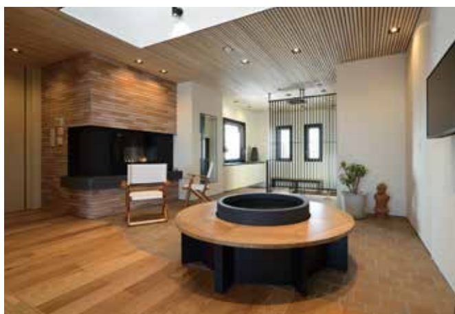
住宅改修工事
