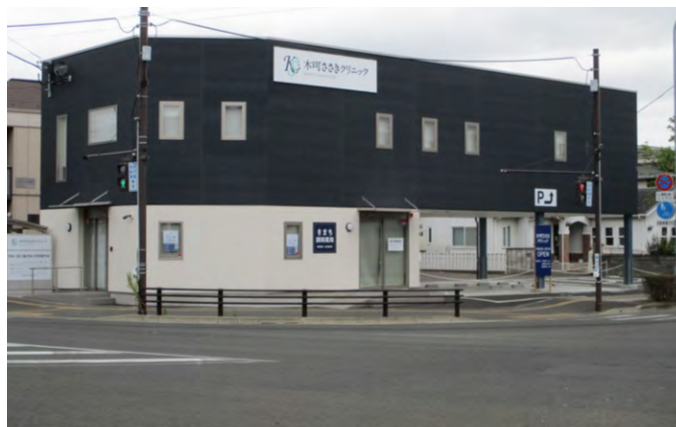
建物新築工事
