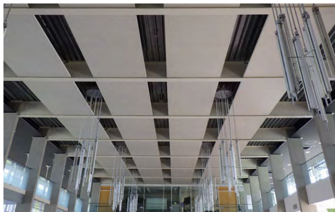
建物耐震改修工事
