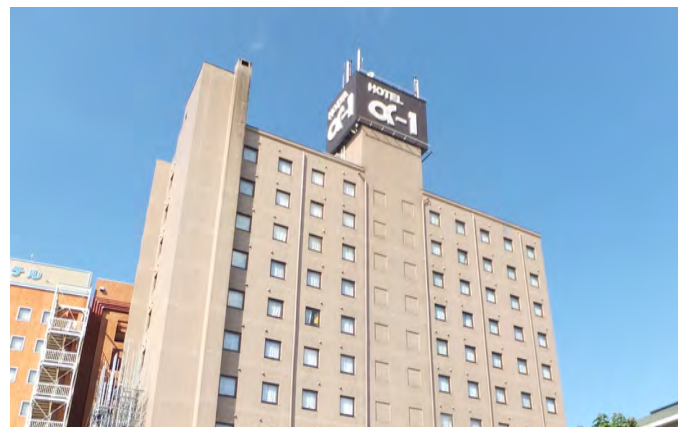
建物外部改修工事
