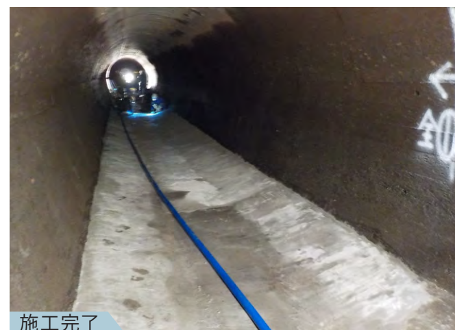
導水路トンネル インバート補修
