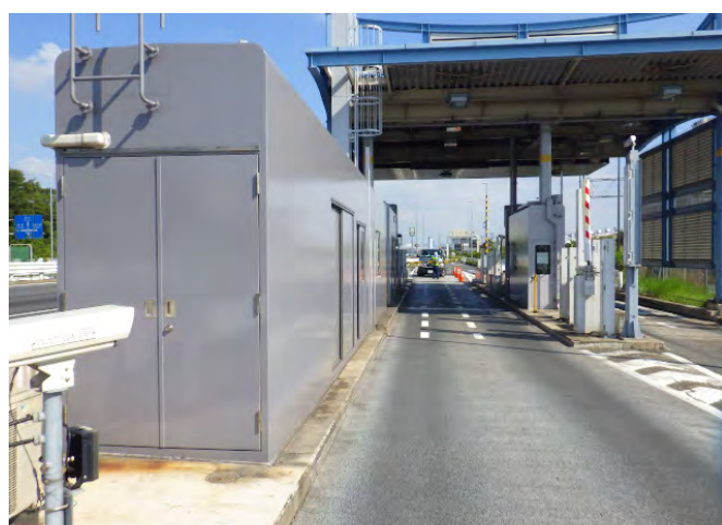
首都高速道路 料金所外装塗装
