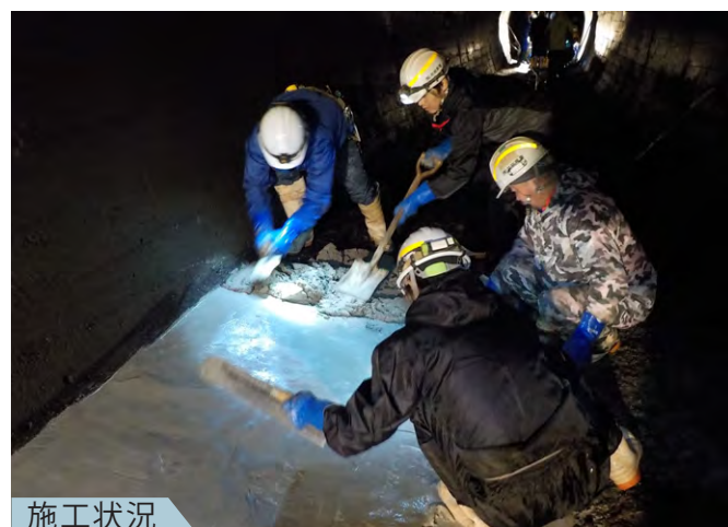
導水路トンネル インバート補修
