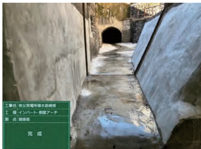
導水路トンネル インバート補修
