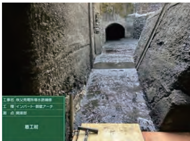
導水路トンネル インバート補修
