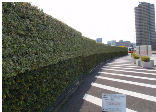
首都高速道路 PA壁面緑化維持
