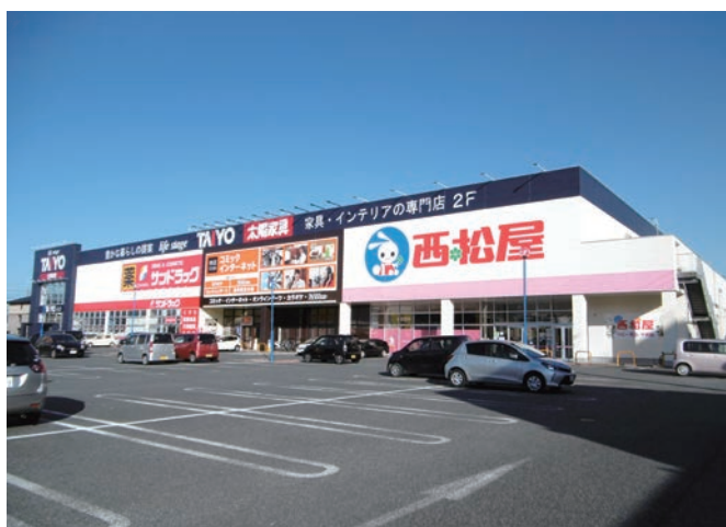
外壁改修工事
