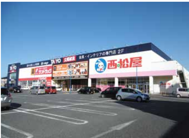
外壁改修工事
