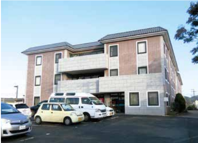
外壁改修工事
