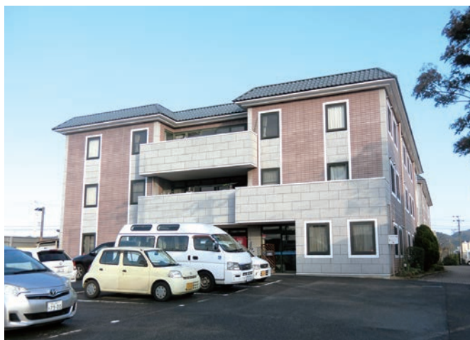
外壁改修工事
