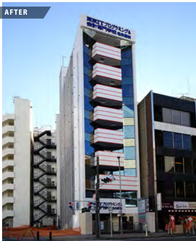
名古屋ビル改修工事（完成）
