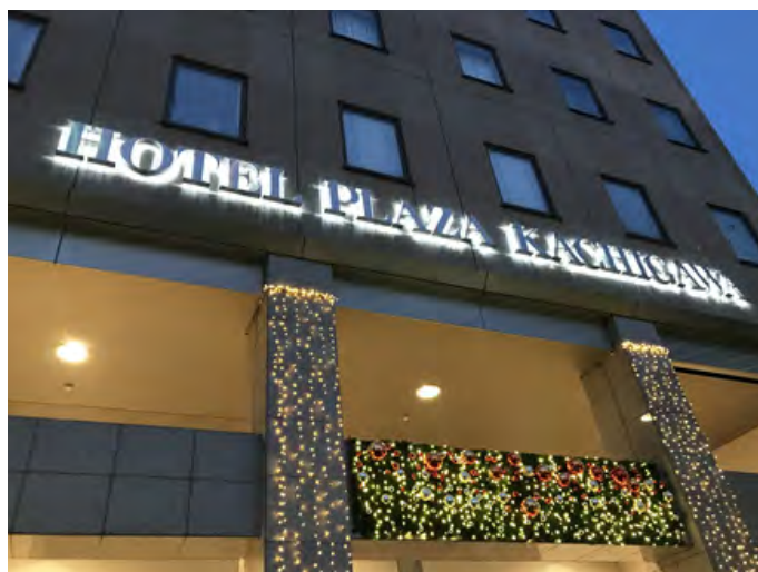
外壁サイン改修工事
