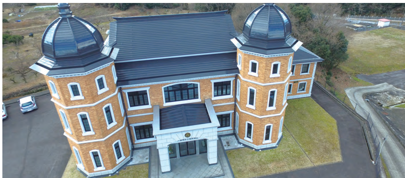
屋根及び外壁改修工事
