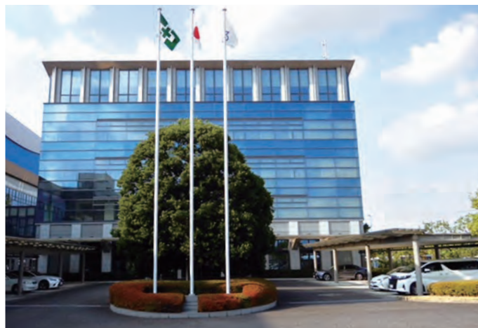
外壁改修工事
