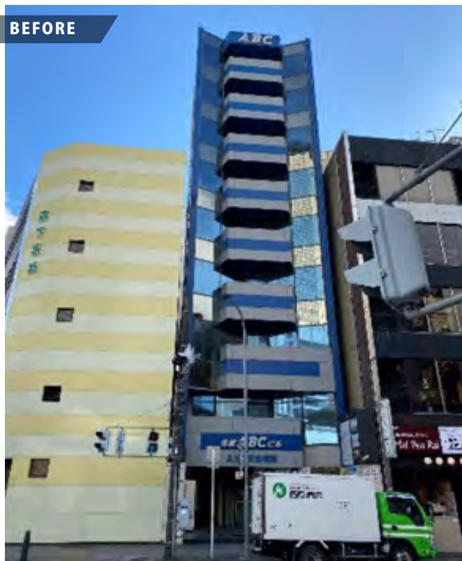
名古屋ビル改修工事（着工前）
