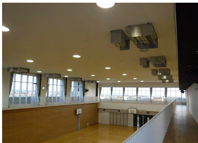
体操室空調新設工事
