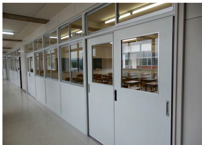
教室間仕切改修工事
