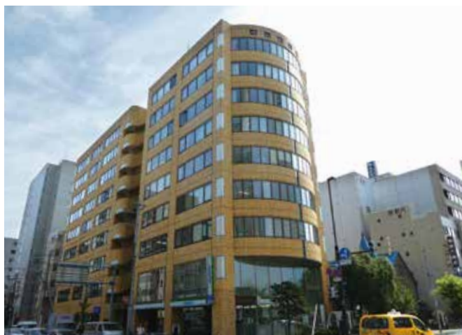
外壁改修工事
