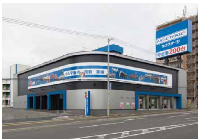
店舗内外装改修
